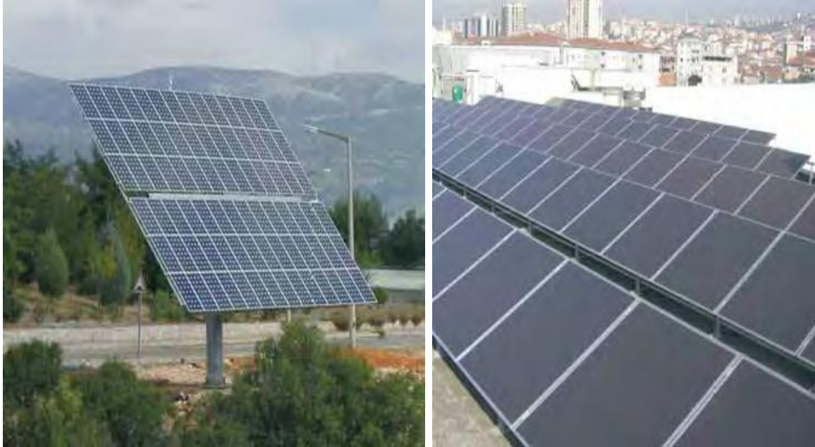
Resim 3 - 15,6 kWp çift eksenli solar izleyici dual-axis solar tracker Muğla Üniversitesi'ndeki PV güç sistemi.
